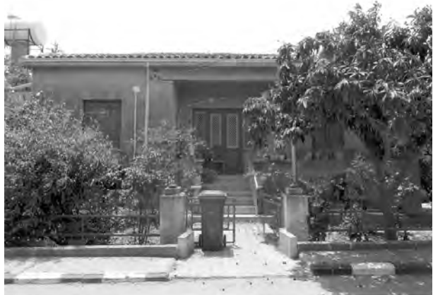
Εικ. 14 Οικία με το κεντρικό δωμάτιο σε υποχώρηση και οριζόντια στοιχείο στήριξης στέγης βεράντας
