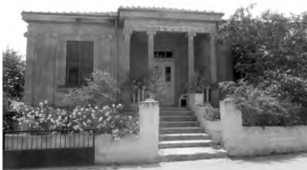
Εικ. 10 Οικία Χαρ. Χατζηδά. Η οικοδομή απομακρύνεται από το οδικό σύνορο και αποκτά επιβλητική σκάλα και χαμηλό περιτείσιμα
