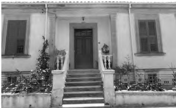
Εικ. 11 Η υπερύψωση των οικιών προστάτευε από την υγρασία και επέτρεπε την κατασκευή υπογείου
