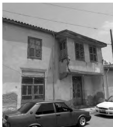
Εικ. 5 Οικία στην οδό Σεραγίου με σαχνισί
