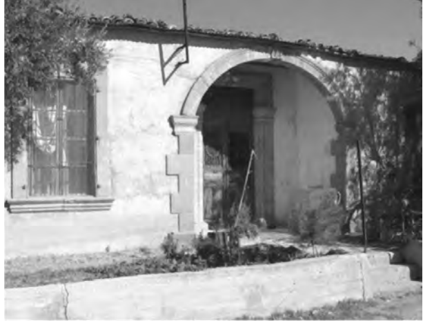
Εικ. 13 Οικία με το κεντρικό δωμάτιο σε υποχώρηση και τοξωτή είσοδο βεράντας
